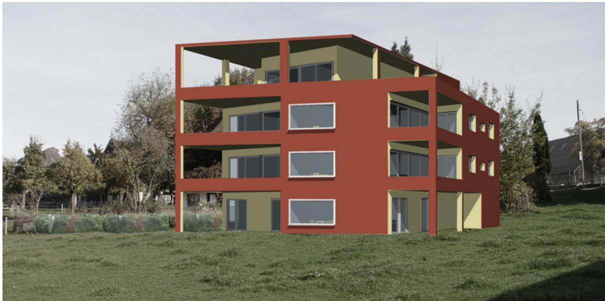
Gebaut im Minergie-Standard
